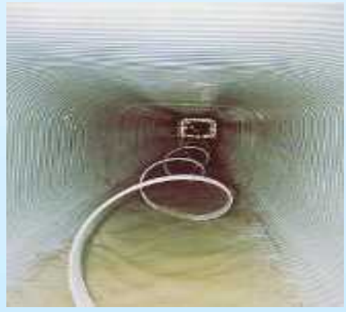
更生工法による長寿命化(下水道)
