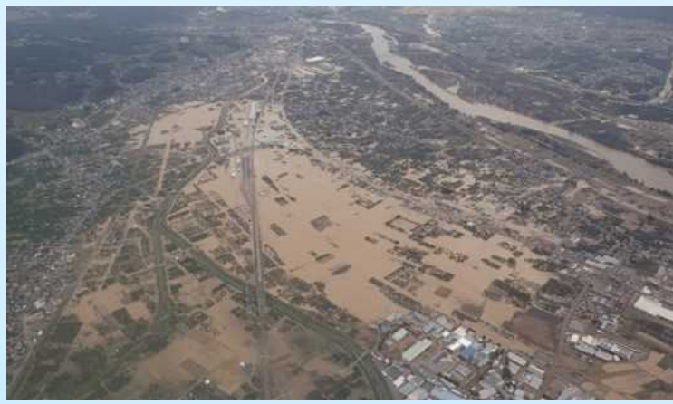
令和元年東日本台風による被害(千曲川)
