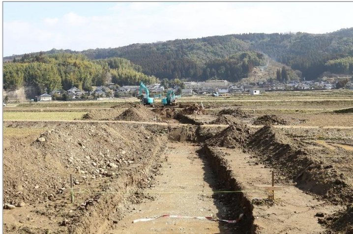
復旧工事（2017年2月）
